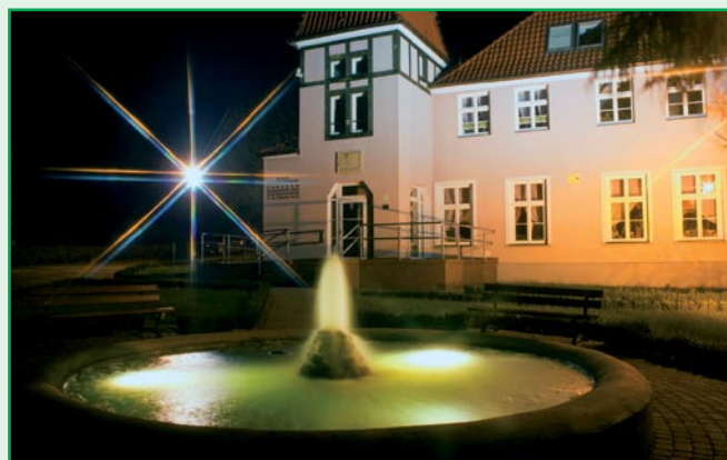
Stan dworku po zakończeniu wszystkich prac, w tym odbudowie zniszczonej fontanny.
