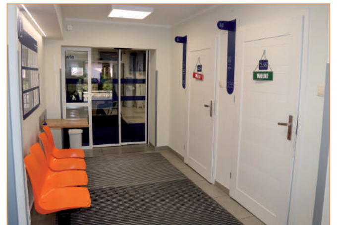
Wykonano dwie pary drzwi przesuwnych, także po to, by ułatwić dostęp do budynku osobom niepełnosprawnym. Dla potrzeb osób niepełnosprawnych dostosowano łazienki.
