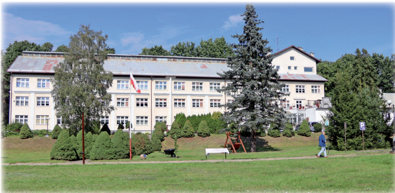
➤ Dom Pomocy Społecznej „Słoneczne Wzgórze” przeznaczony jest dla 180 osób dorosłych przewlekłe psychicznie chorych. Obecnie dom posiada trzy budynki mieszkalne bez barier architektonicznych.
